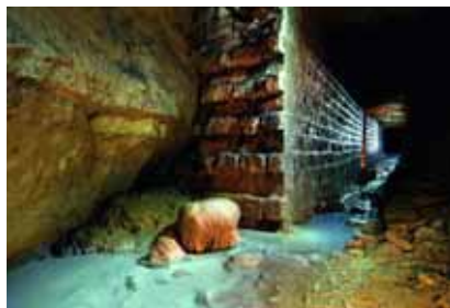
één van de gangen onder Porte des Lilas
